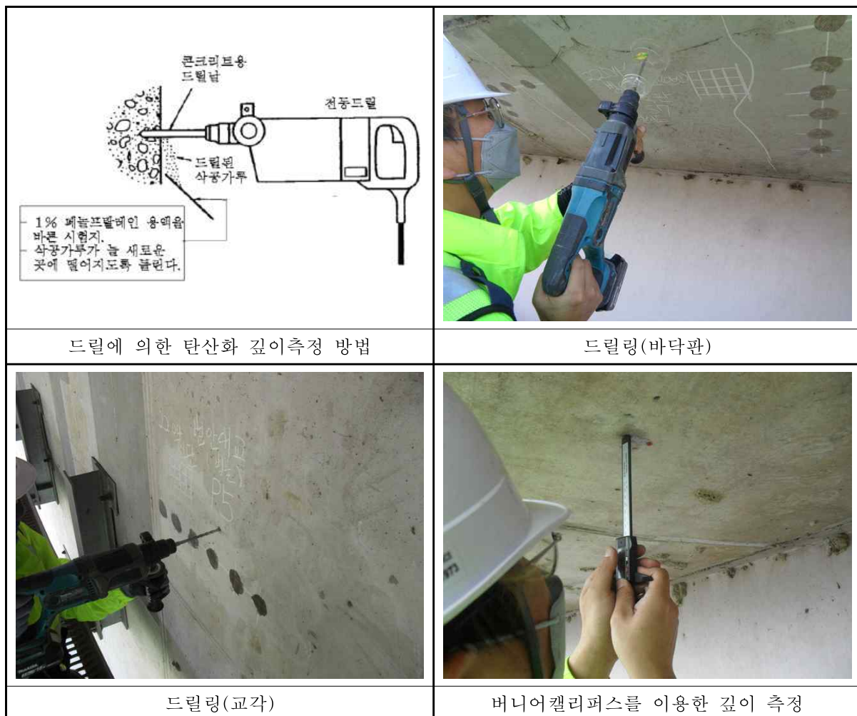
<그림 3.12> 드릴에 의한 탄산화 깊이 측정
