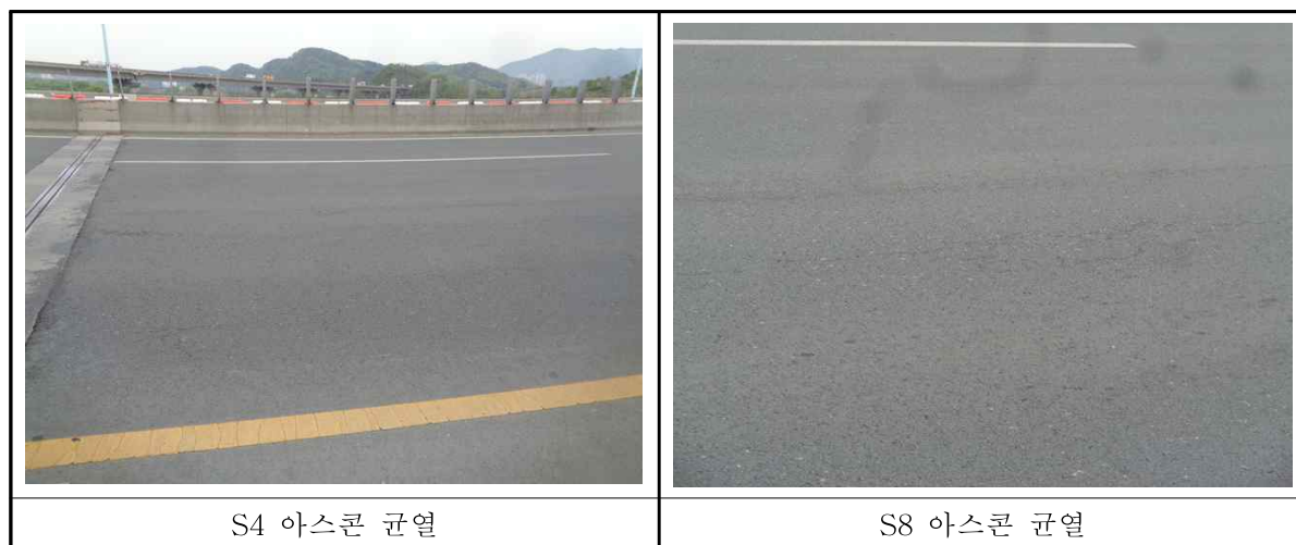
<표 3.22> 범물방향 교면포장 외관조사 결과
